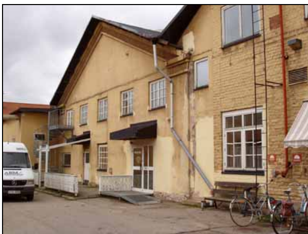
Gjuteriets gavelfasad mot gården.
