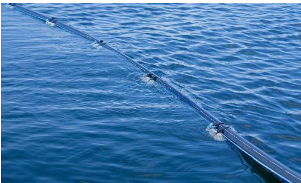
Figur 9. Ledning med vikter vid sjösänkning. Källa: http://www.sjovikt.se
