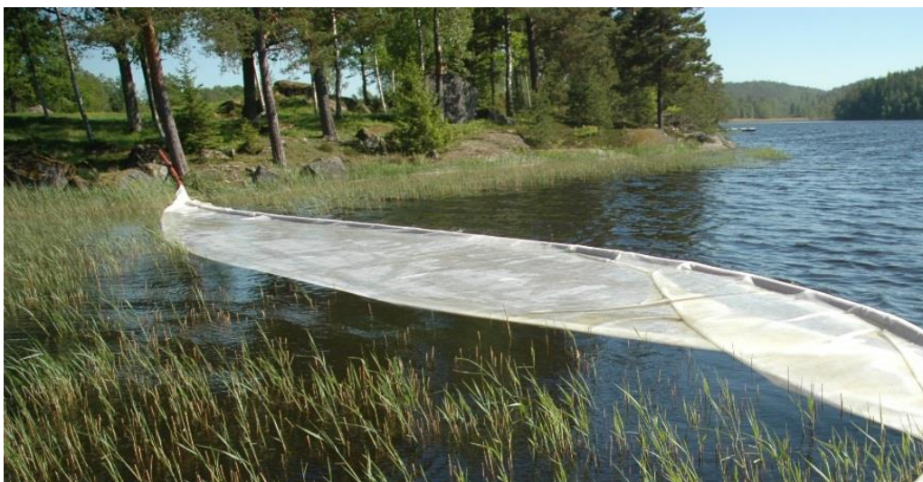
Figur 14. Exempel på bottengående skärm. Källa: http://nuva.se/wp-content/uploads/2012/08/DSC_0448.jpg
