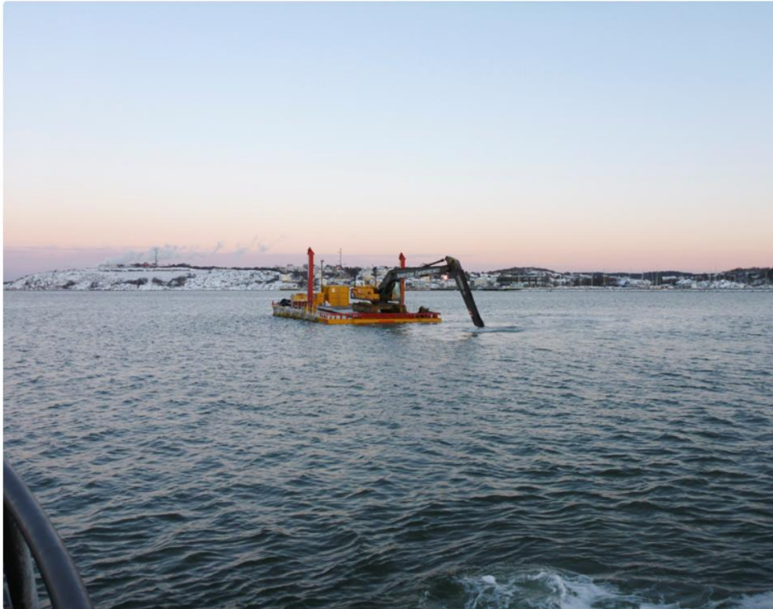
Figur 2. Schakt för sjöledning. (Ivarssons Entreprenad, Asperö Tångudden, Södra skärgården 2013.)
