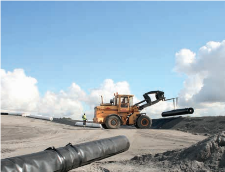
Sluttäckning pågår på flera av våra deponier. På deponin Sänkmossen i Fagersta har sluttäckningen färdigställts under 2018.
