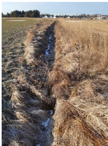
Diket sett från väg 517
