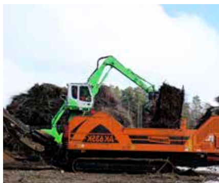
En större investering har gjorts i krossutrustning; två krossmaskiner, två lastmaskiner och en materialhanterarmaskin.
