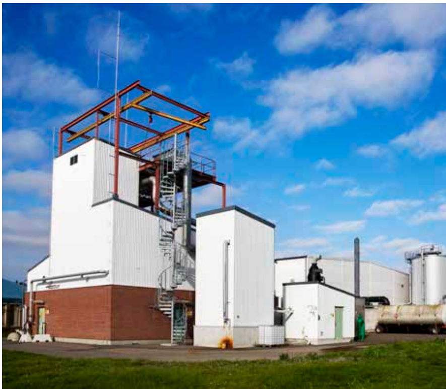
Biogasanläggningen på Gryta. Till vänster i bild ses uppgraderingsanläggningen för biogas. Till höger syns den runda rötammaren.
