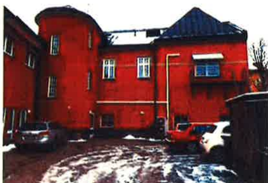
Fasad mot gård (nödutgång)
