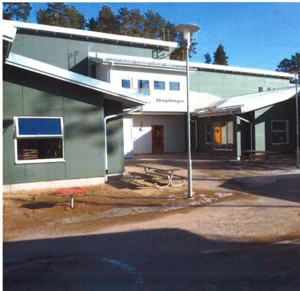
Ny förskola Nybygget Skogsborgen, med plats för 135 barn, invigdes i början av året.
