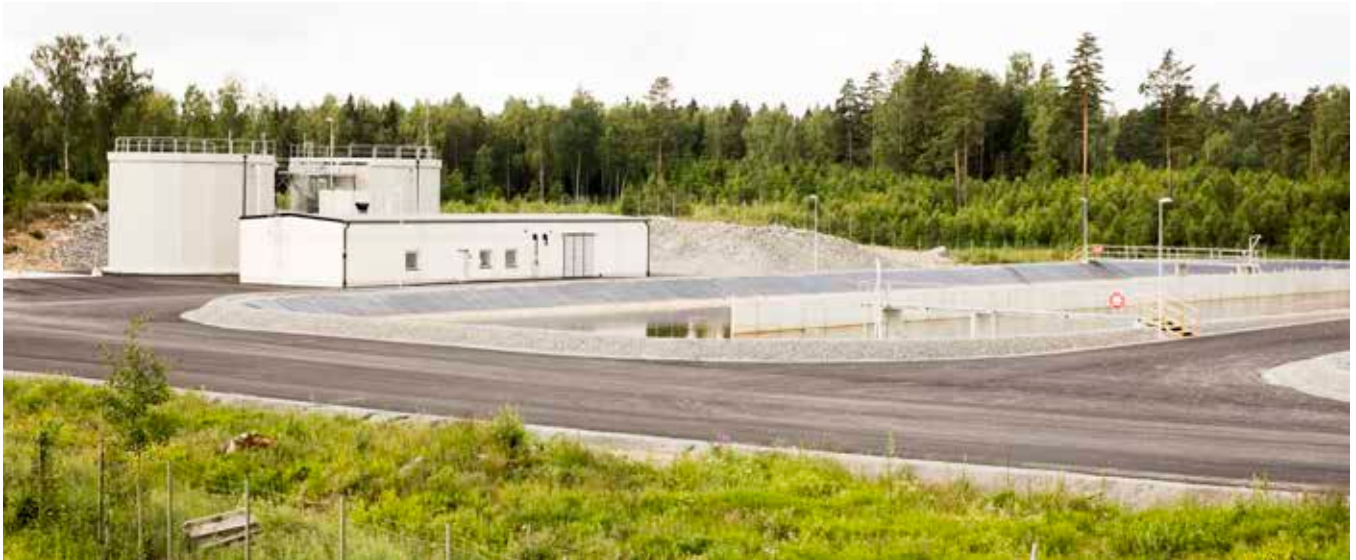
I den nya SBR-anläggningen renas lakvatten. Det reade vattnet leds sedan ut i Svartån.
