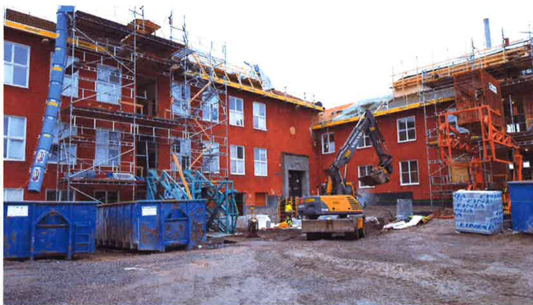
Renovering av S:t Olovsskolans annexbyggnad, maj 2016.
