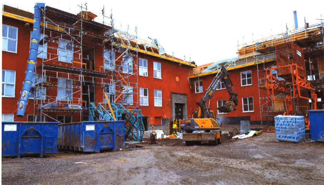
Renovering av S:t Olovsskolans annexbyggnad, maj 2016.
