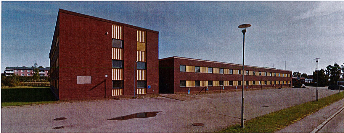
Befintlig hotellbyggnad med tillhörande parkering. Foto taget från sydväst.
