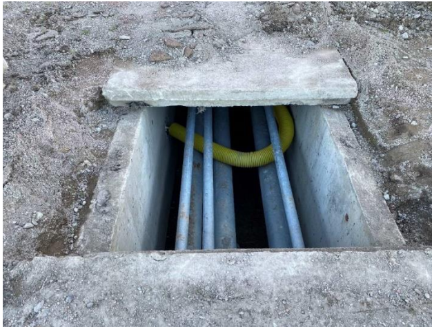
Figur 19. Befintlig kulvert från kylmaskinrum till bandypist kan återanvändas för nya matarrör till ny ispist.
