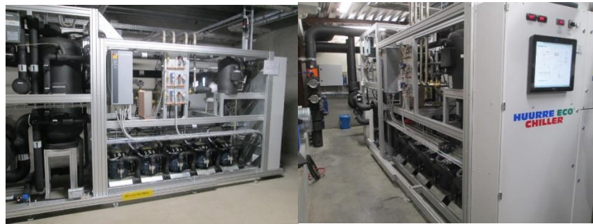
Figur 12 Indirekt CO 2 -system med ammoniakvatten som köldbärare.
