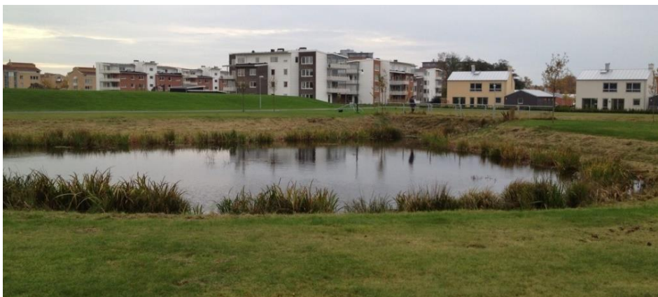
Figur 6. Öppen magasinering med damm. Exempel från Falkenberg, Kristineslätt.
