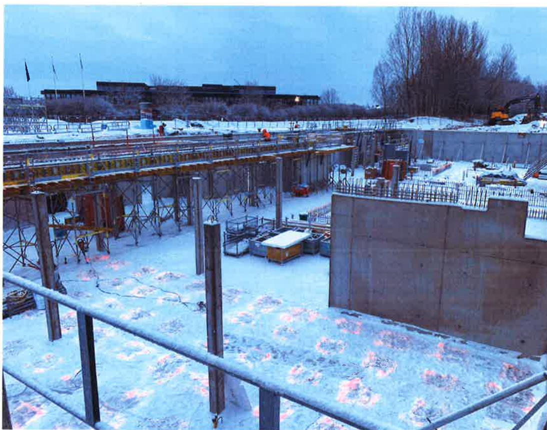
Byggnation av badhus och idrottshall, vintern 2018/19. Källaren under badhuset gjuten.
