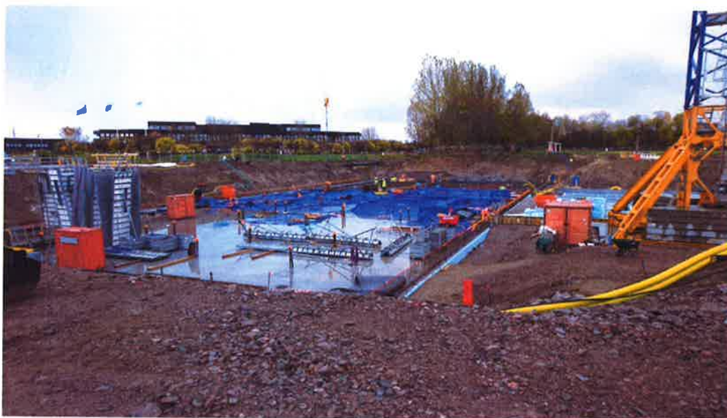
Byggnationen av det nya badhuset och den nya idrottshallen påbörjad. Oktober 2018
