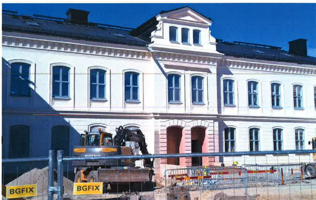
Renovering av S:t Olovsskolan, etapp 1, huvudbyggnaden, maj 2015
