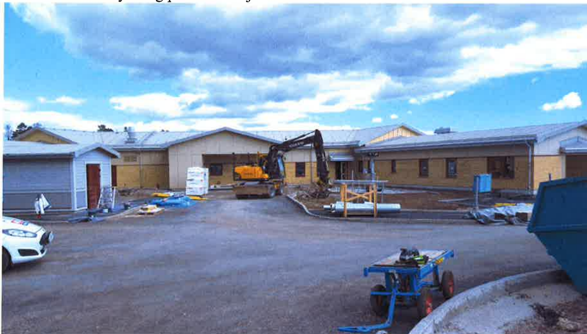
Byggnation av nya förskolan Kompassen, april 2016.
