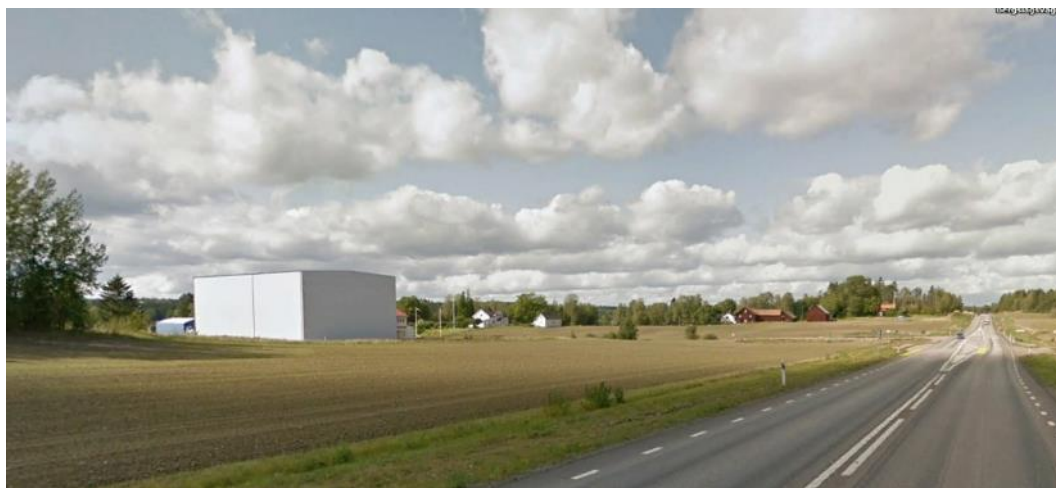
Anläggningen med befintligt höglager sett från söder
