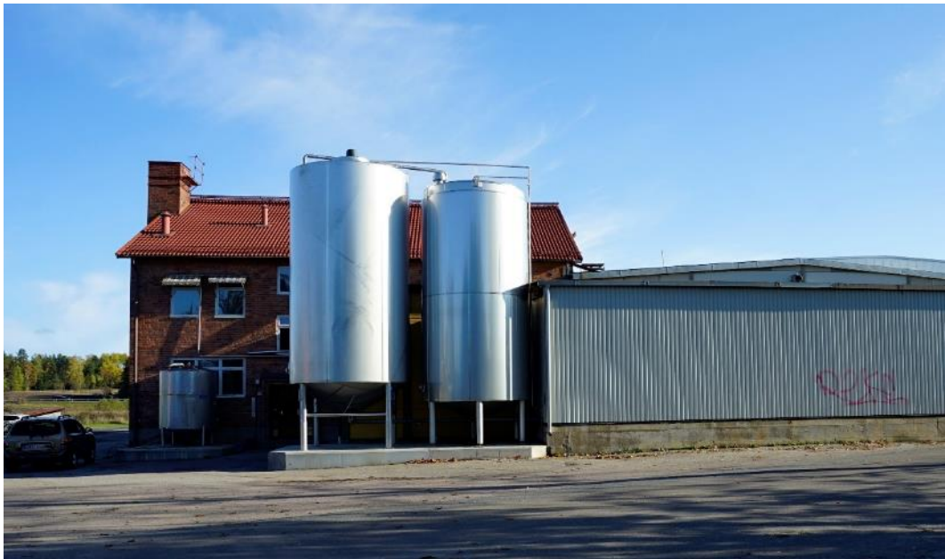
Tegelbyggnaden med vidbyggd produktionslokal
